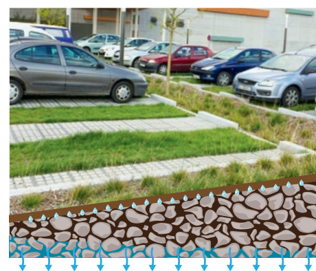
Parking en dalles-gazon et dalles-pavés
