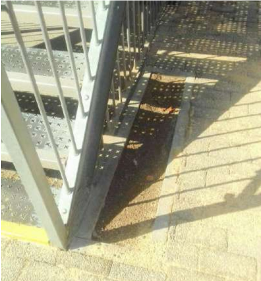
Fosse pour grimpante sur la structure
