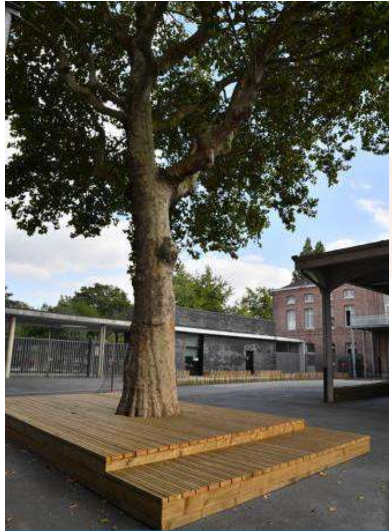
Structure bois pour agrandir et protéger la fosse
