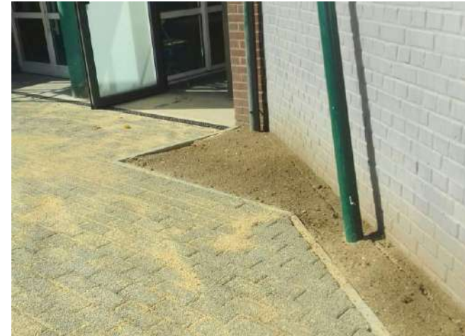
Fosses de plantation et pavés drainants
